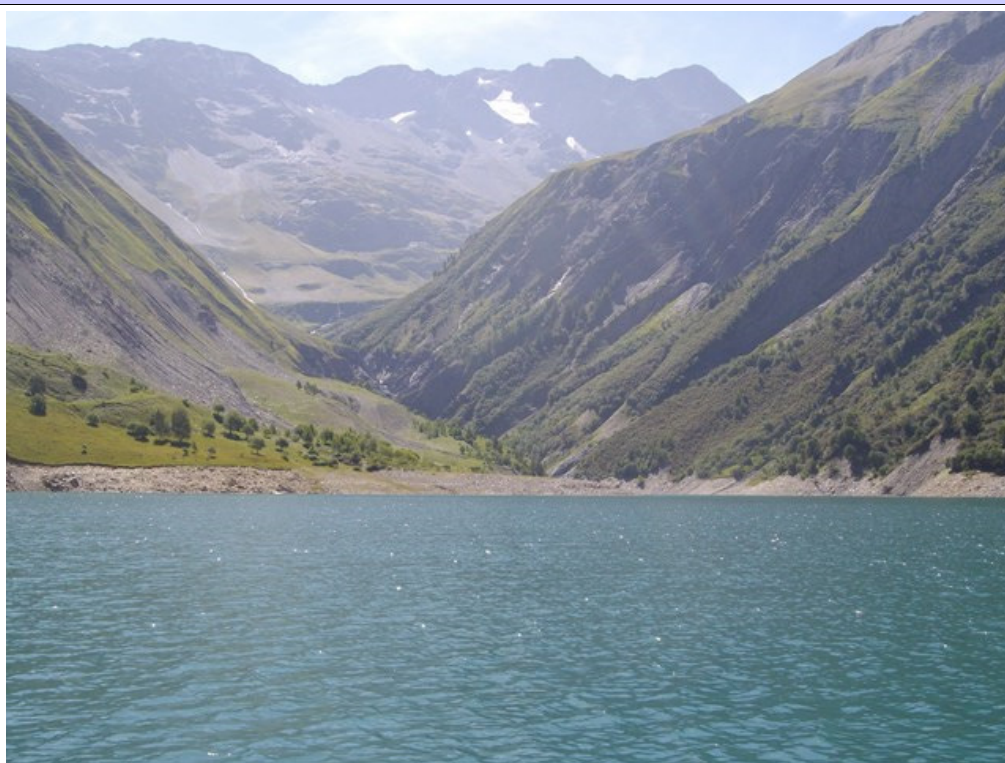
RETENUE DE GRAND' MAISON (crédit photo : STE, 2017)
