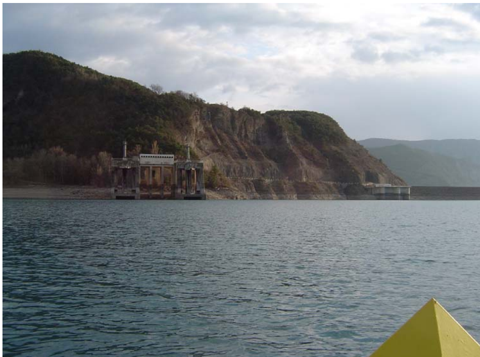
Vue sur la prise d'eau du barrage de Serre Ponçon depuis le point de prélèvement
