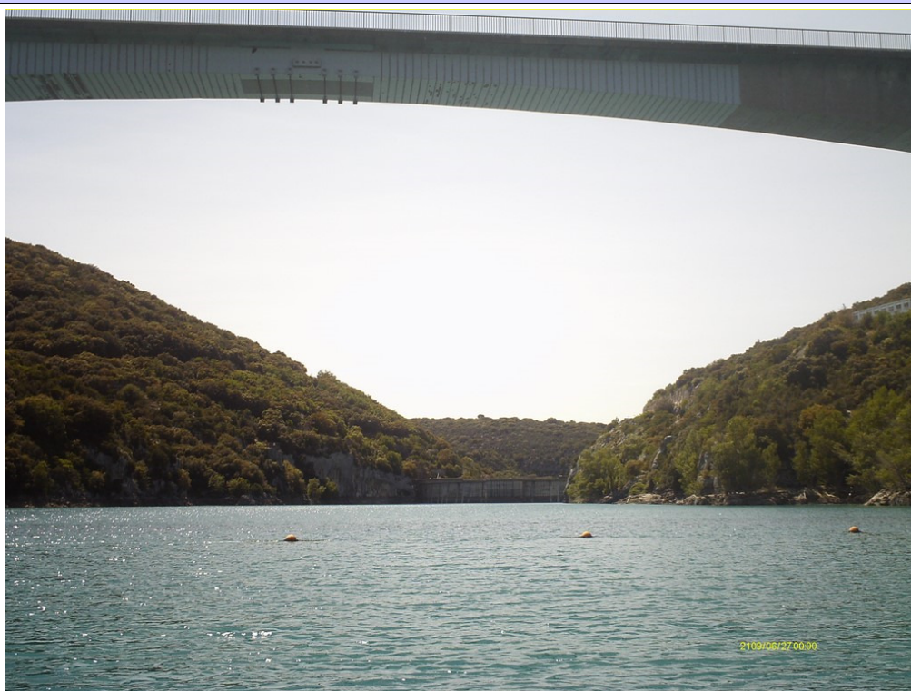
Barrage de Sainte Croix- (Crédit photo STE mai 2019)
