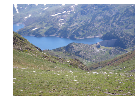
▲ Partie aval de la retenue depuis le chemin d'accès
