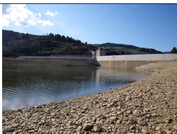
photo 1 : Vue sur l'aval de la retenue depuis la rive droite à proximité de L2
