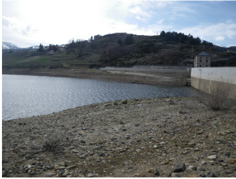
▲ Partie aval de la retenue depuis l'accès en rive droite
