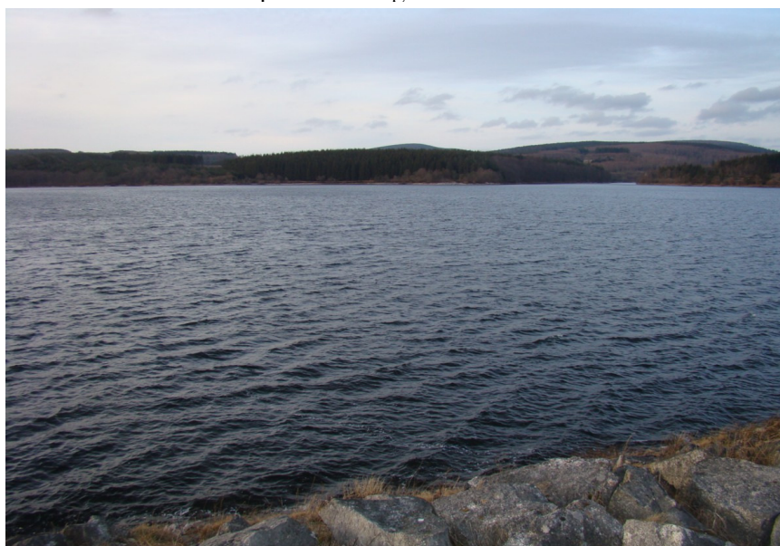
Photo du site : depuis le barrage
