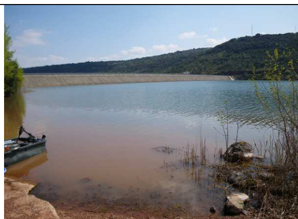
photo 1 : Vue sur l'aval de la retenue depuis la rive gauche à proximité de L2
