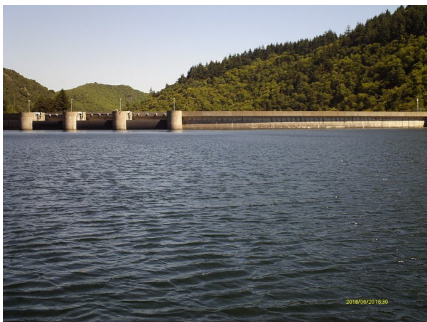
Réservoir d'Avène (crédit photo : STE, mai 2018)
