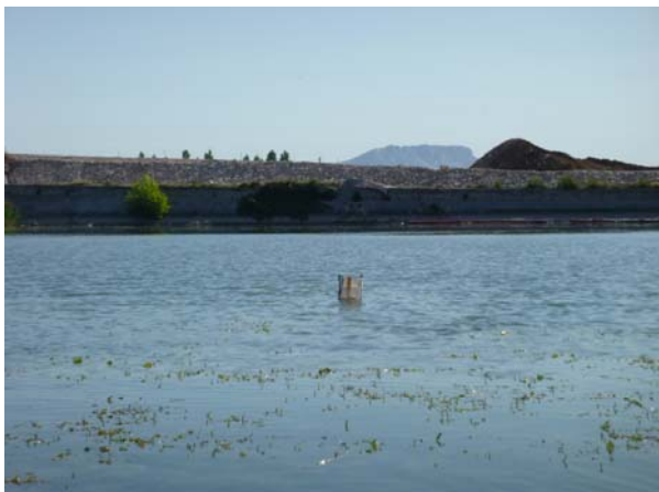
Retenue du Réaltor UO n°11
