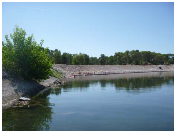
Retenue du Réaltor UO n°11
