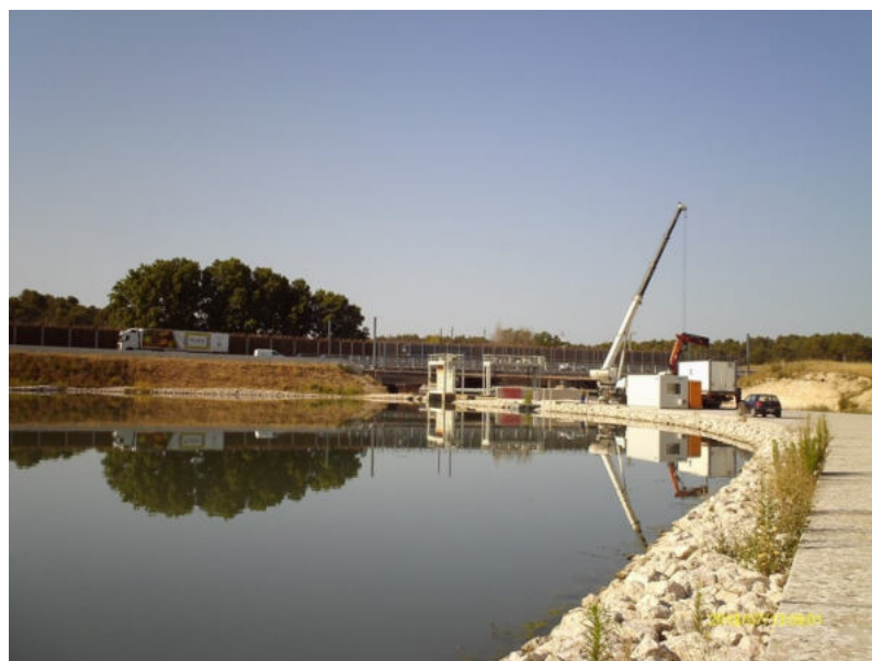
Bassin du Réaltor (crédit photo : STE, juillet 2018)
