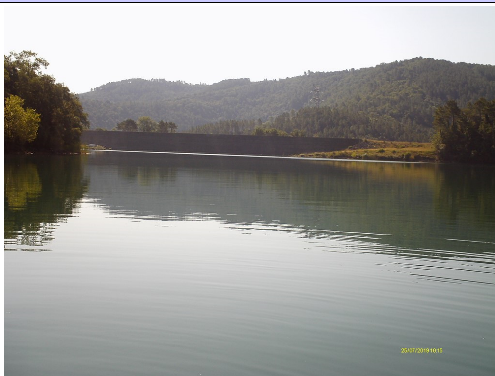
Retenue de Saint Cassien (crédit photo : STE, juillet 2019)
