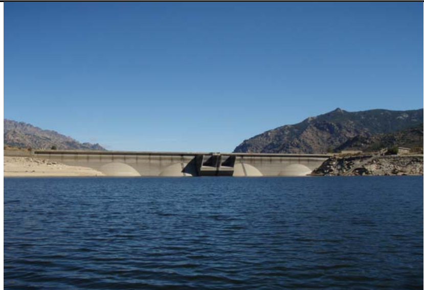
Photos du site :
