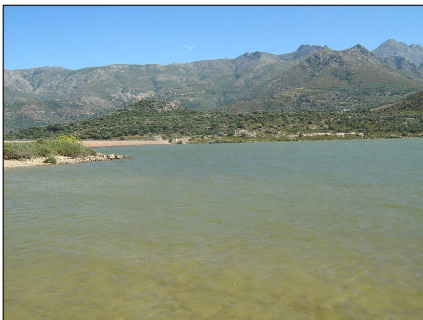
Figure 10 : vues générales sur la retenue
