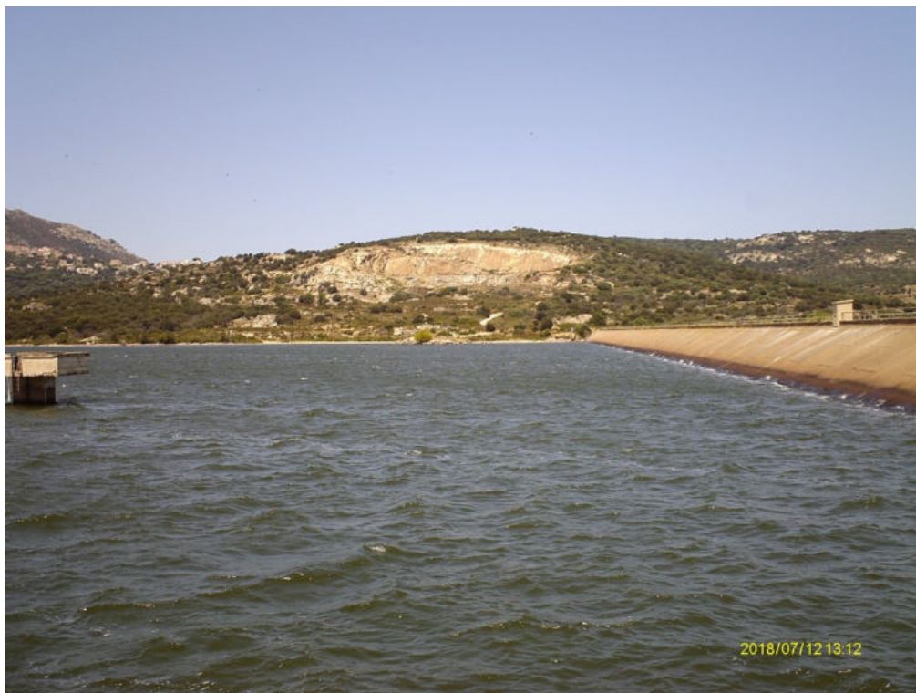
Retenue de Codole (crédit photo : STE, mai 2018)
