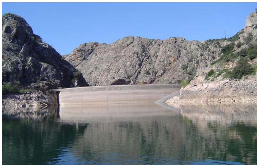
Retenue de Tolla, vue sur le barrage depuis le site de prélèvement
