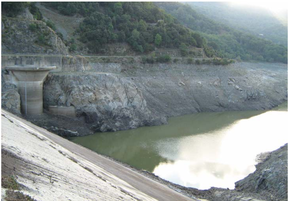
Retenue d'Alesani, vue depuis le barrage
