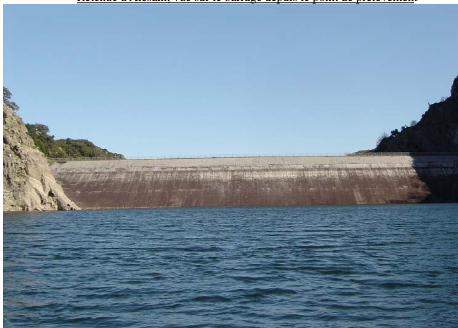
Retenue d'Alesani, vue sur le barrage depuis le point de prélèvement
