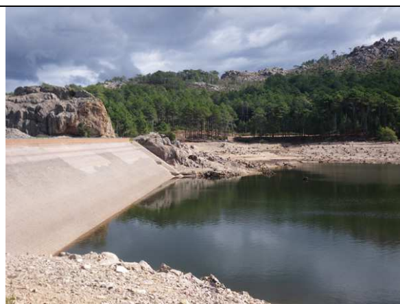
Photo 1 : vue sur la partie Sud-Est du plan d'eau depuis la rive à proximité du point L2
